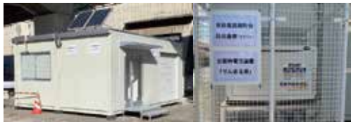
江東区・東砂葛西橋町会様で導入頂きました。
